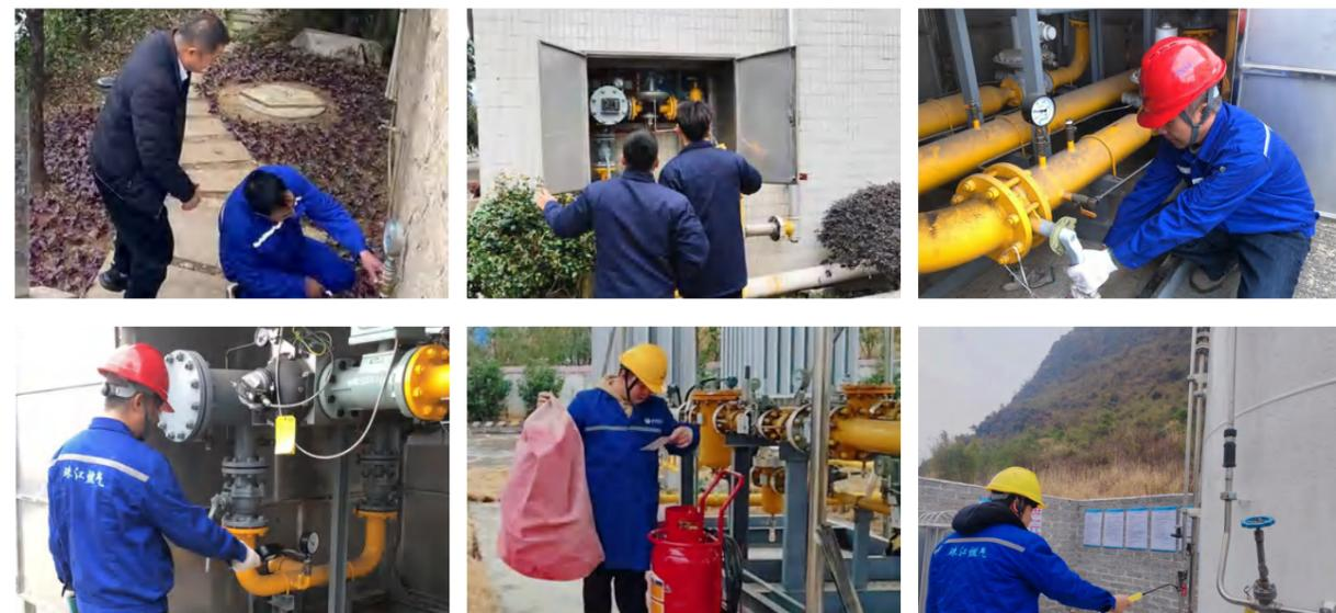
公司组织对各子公司场站、区域调压设备运行情况进行全面的检查，仔细查看燃气调压箱(柜)、燃气管道、管道接头、燃气软管等设施，对现场发现的问题立即安排整改，及时排除隐患；对站内的灭火器等消防设施进行检查维护，确保压力指示正常，消防设施设备零部件完好无损。
