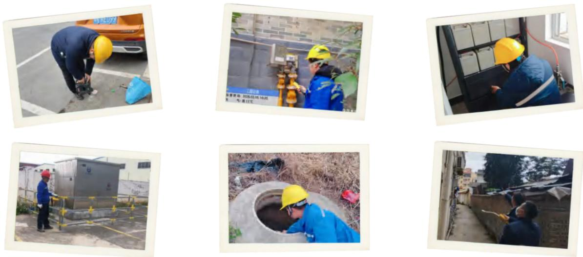
为进一步保障居民用气安全，珠燃人挨家挨户上门检查，用专业仪器对用户燃气管道、阀门、燃气表、燃气灶具等设施设备“听诊把脉”，逐一排查是否存在泄漏、老化、损坏等隐患，耐心解答居民用户的燃气使用问题，用专业与勤恳守护万家灯火，筑牢“燃气”安全防线。
